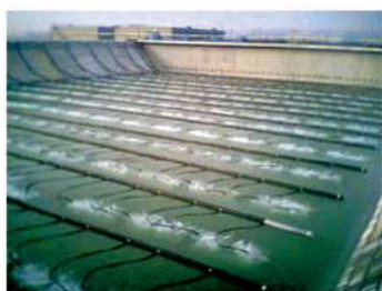
悬挂链、可提升微孔曝气
