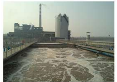
汇胜集团1万m 3 /d污水处理工程
