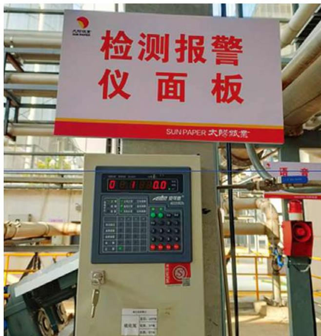
图8 有限空间外部安装有有毒有害气体检测仪显示面板
