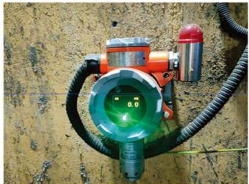
图7 有限空间内部安装有有毒有害气体检测仪
