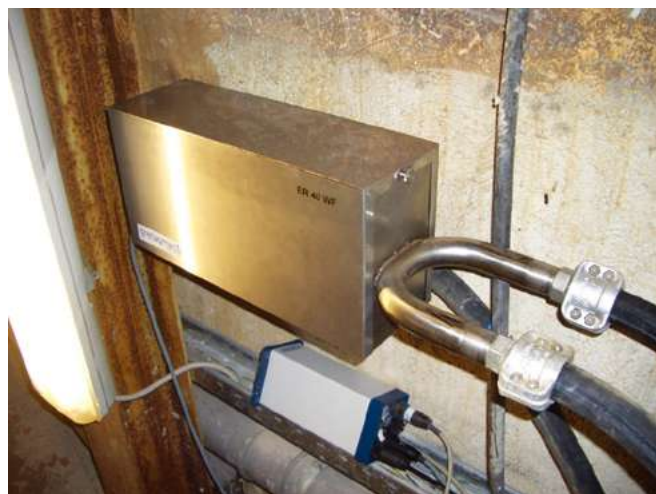
图3 浆料测量安装现场
