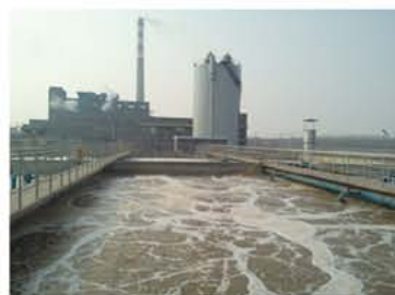
汇胜集团1万m 3 /d污水处理工程
