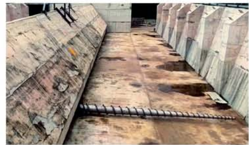
木片仓行走出料螺旋 (悬臂结构: 长15m, 双端支撑结构: 长18m)
