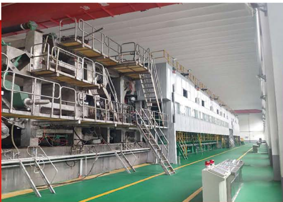
沂水华淦现场实景照
