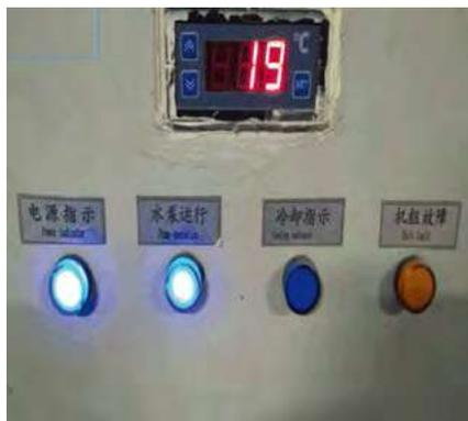
图18 冷却水站的温度指示
