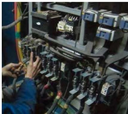
图5 低压大功率接触器触点维护
