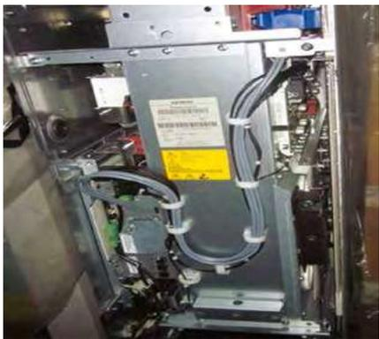
图9 SIEMENS S120系列变频器模块
