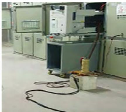
图3 真空断路器绝缘打压3.5kV测试
