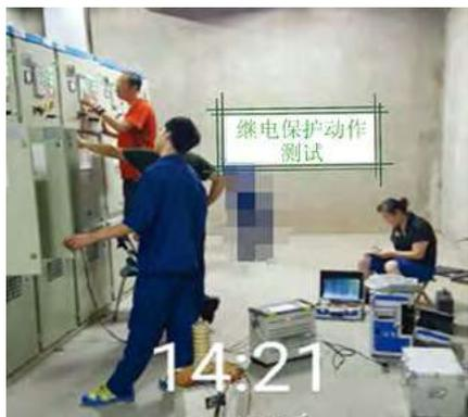
图4 高压综合保护器继电器保护动作测试
