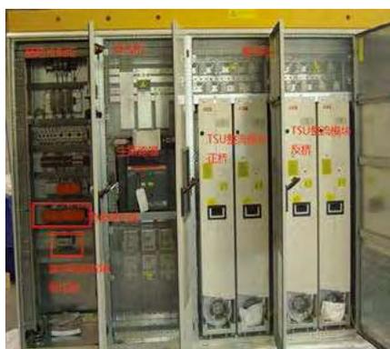
图6 ABB传动柜结构及组成部分
