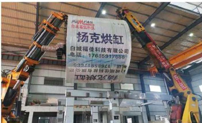
安装中的烘缸直径4877mm
