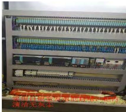
图14 DCS控制柜的密封
