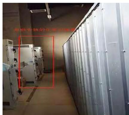
图15 单独安装的化学过滤器
