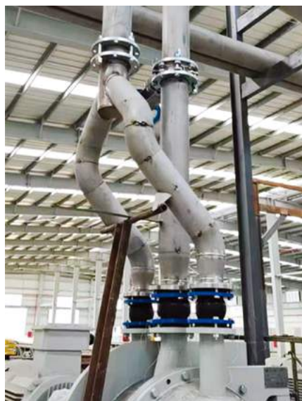
图7 进浆管的管道布置
