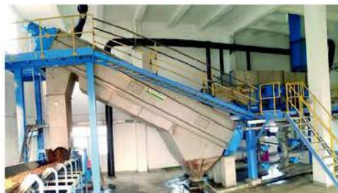
木片水洗及废水零排放处理系统 (最大处理能力: 1200m 3 /h)
