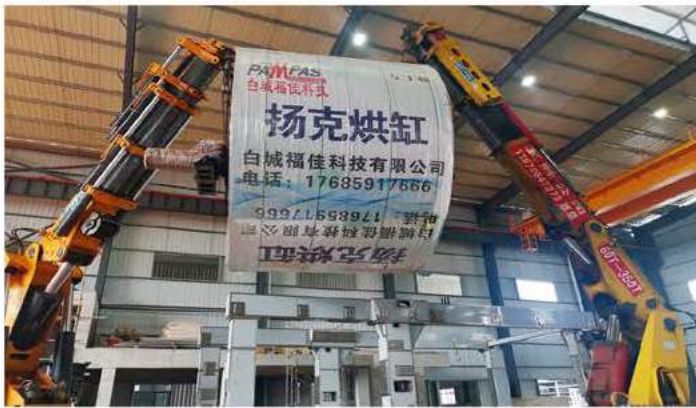
安装中的烘缸直径4877mm
