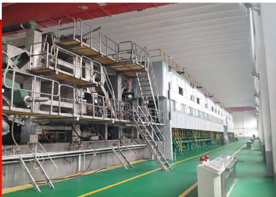
沂水华淦现场实景照
